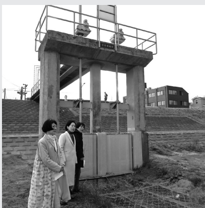
堰1、2丁目の浸水被害は下水道からの逆流が原因。宇奈根排水樋管を畑野君枝衆議院議員、石田和子県議員とともに視察。
