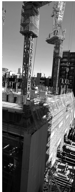
現在建設中の川崎市新庁舎
